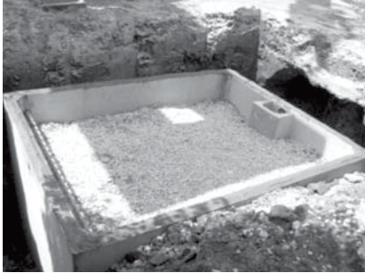
Letti percolatori aerobici ed anaerobici
